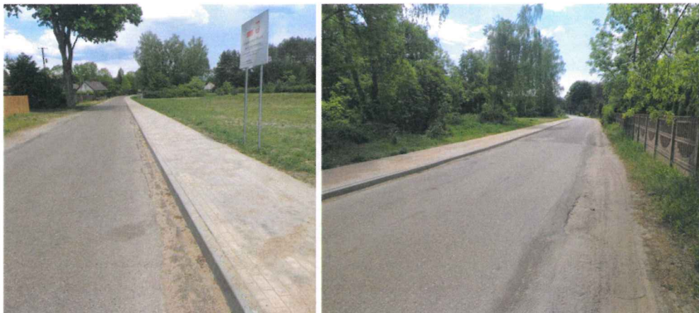
Fot. Powiatowy Zarząd Dróg w Pisz Budowa chodnika w ciągu drogi powiatowej Nr 1518N w m. Karwica
