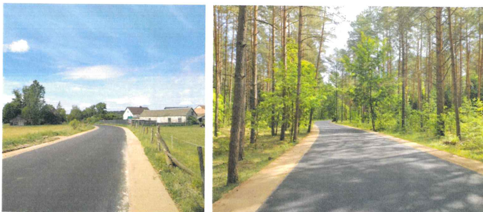
Fot. Powiatowy Zarząd Dróg w Pisz Przebudowa drogi powiatowej Nr 1674N – Orłowo – Zabelne – DW Nr 667 od km 0+000 do km 2+750
