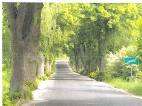
Fot. Powiatowy Zarząd Dróg w Pieszu Remont drogi powiatowej nr 1696N Mikołajki – Łuknajno – Tuchlin – DK nr 16 – stacja kolejowa Tuchlin od km 6+572 do km 7+507
