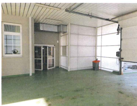
Fot. SP ZOZ Szpital Powiatowy w Pisz Posadzka z żywicy epoksydowej w komorze przyjęć ambulansów SOR
