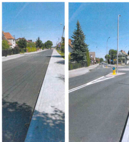
Fot. Powiatowy Zarząd Dróg w Pisz Przebudowa drogi powiatowej Nr 4637N – ulicy Mazurskiej w Pisz
