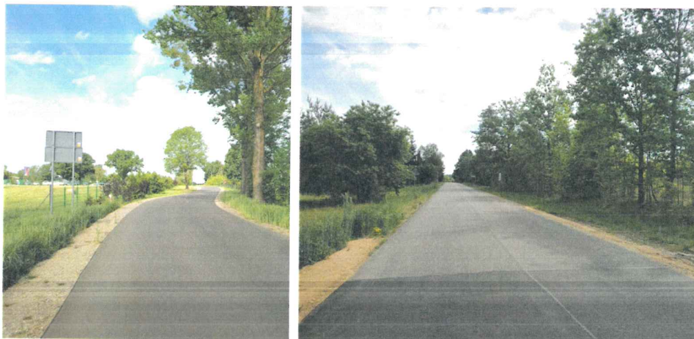
Fot. Powiatowy Zarząd Dróg w Pisz Modernizacja drogi powiatowej Nr 1660N DK Nr 63 – Kałużyn – DK Nr 58 (Biała Piska) od km 1+015 do km 1+915
