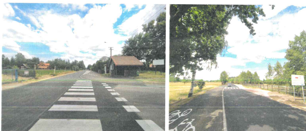
Fot. Powiatowy Zarząd Dróg w Pisz Przebudowa (rozbudowa) drogi powiatowej Nr 1686N od km 0+300 do km 2+757 w m. Karwik
