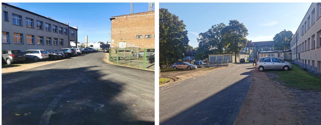
Fot. SP ZOZ Szpital Powiatowy w Pisz Remont drogi wewnętrznej
