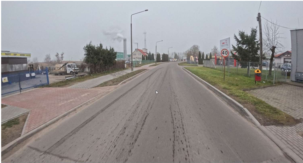
Fot. Powiatowy Zarząd Dróg w Pieszce Remont drogi powiatowej Nr 4616N (ul. Jagodna) od km 0+044 do km 0+361
