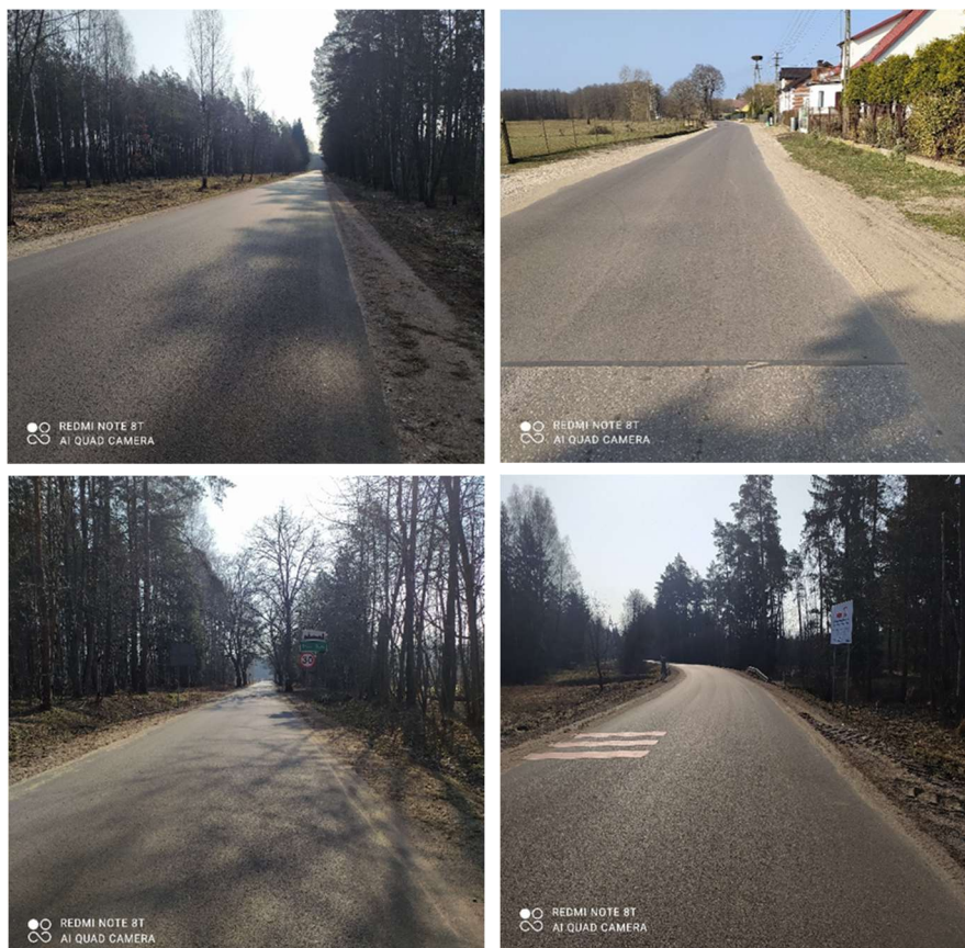
Fot. Powiatowy Zarząd Dróg w Pisz Remont drogi powiatowej Nr 1664N (Stare Guty) od km 0+340 do km 2+037
